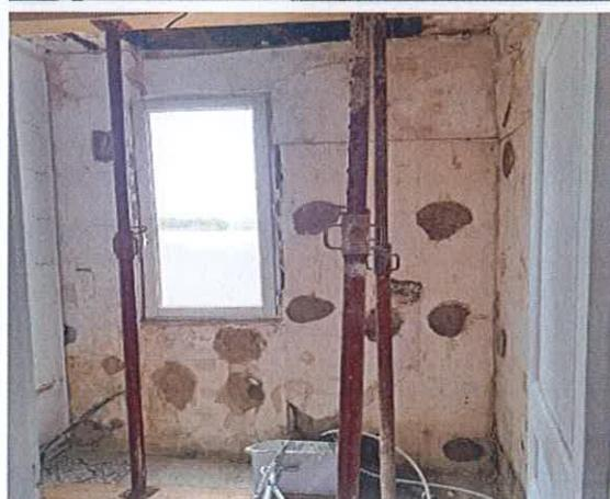
L'assurance de \_\_\_\_\_ a installé des poutres de maintien pour soutenir l'entresol car il peut s'effondrer à tout moment.
