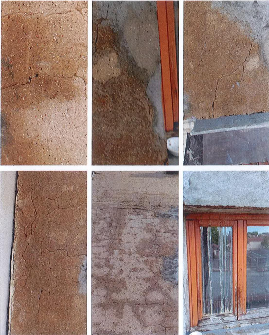
La fuite a été en partie absorbé par le mur extérieur qui reste toujours mouillé car l'infiltration d'eau se fait par l'intérieur.
