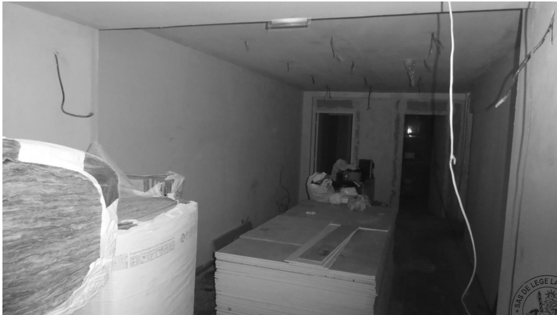
17 L'ensemble est en cours de travaux
