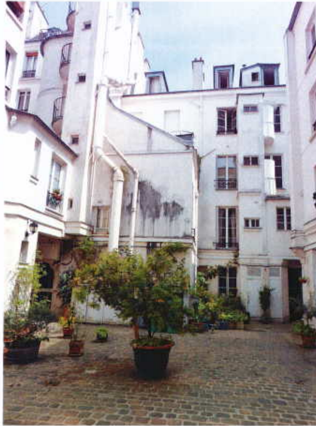
Cour de l'immeuble
