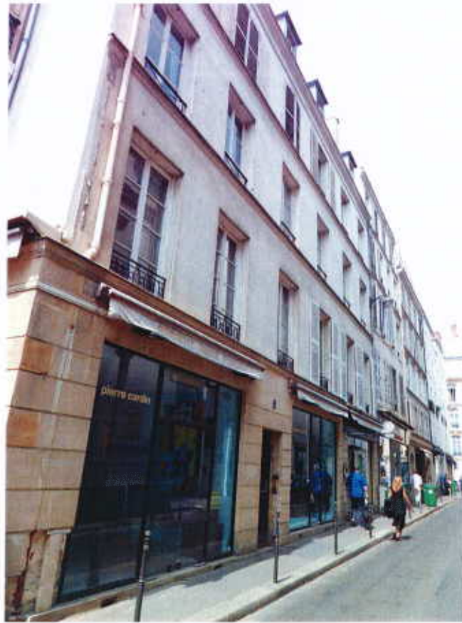
Façade sur rue du 3 rue Duras
