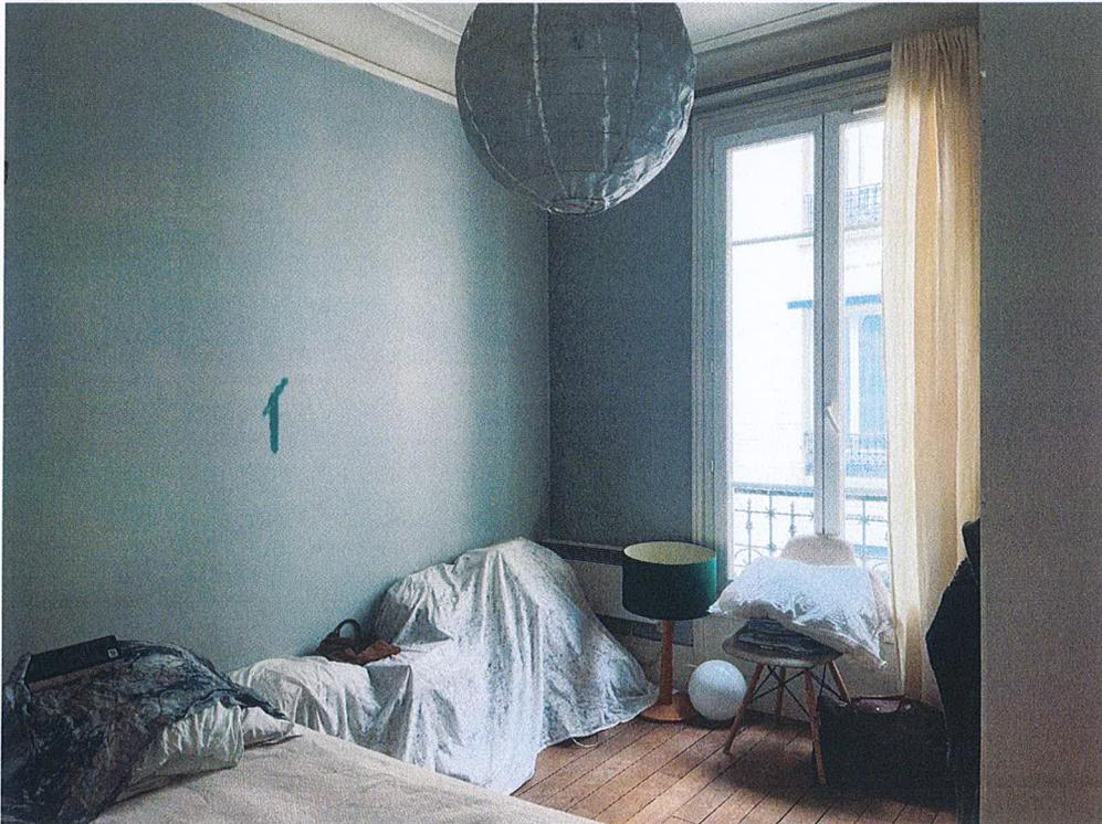
Les murs sont recouverts d'une peinture grise ternie. Je relève des écaillages, des traces d'infiltrations ocre à hauteur du soubassement sur la gauche, ainsi que des écaillages sur le mur de gauche également en partie basse.
