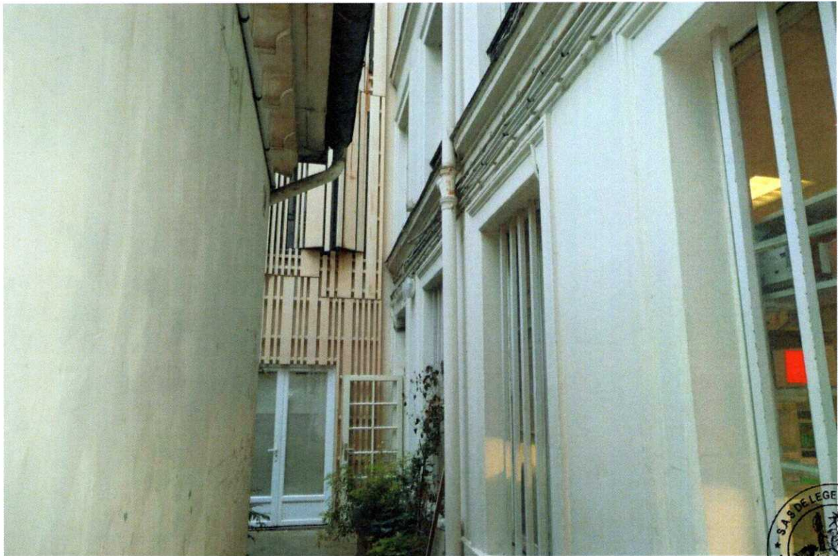
19 Cour arrière commandant le bât B
