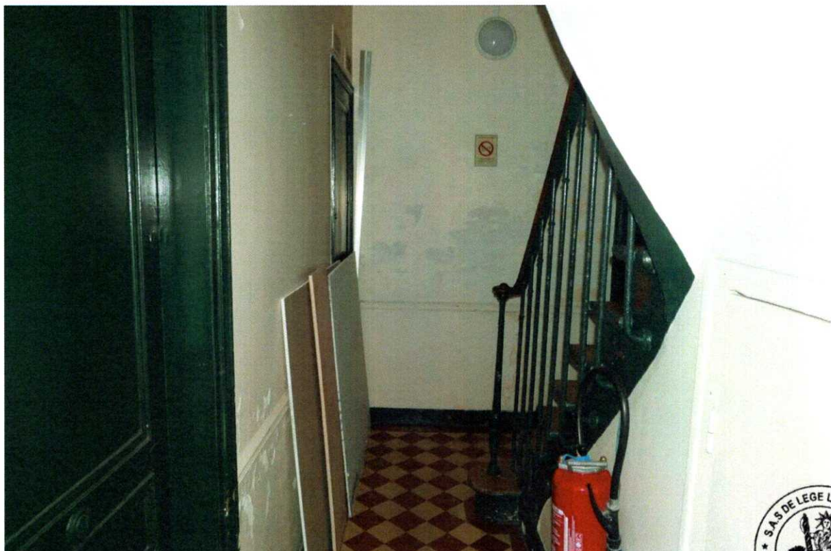
20 Hall Bât B
