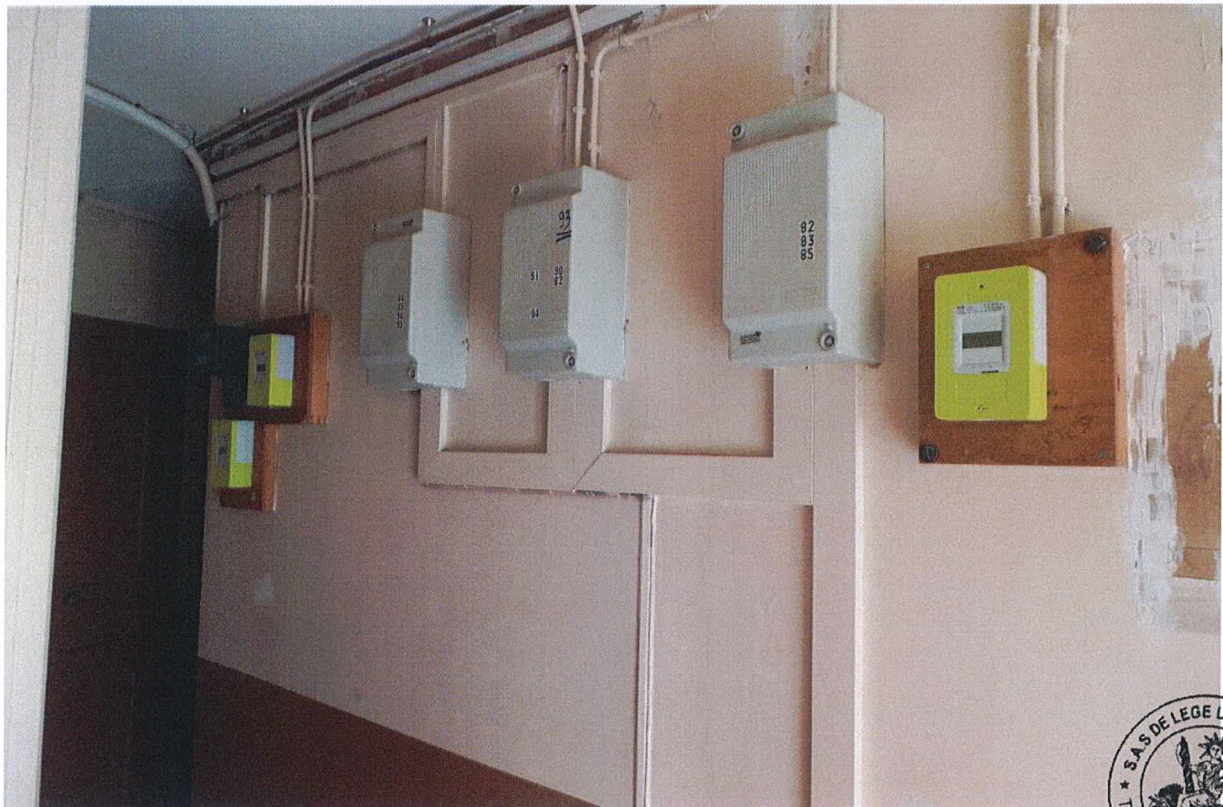
14 Compteur Linky sur le palier
