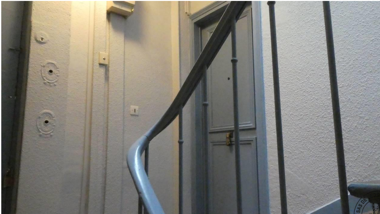
5 Porte de droite sur le palier du 3 ème étage
